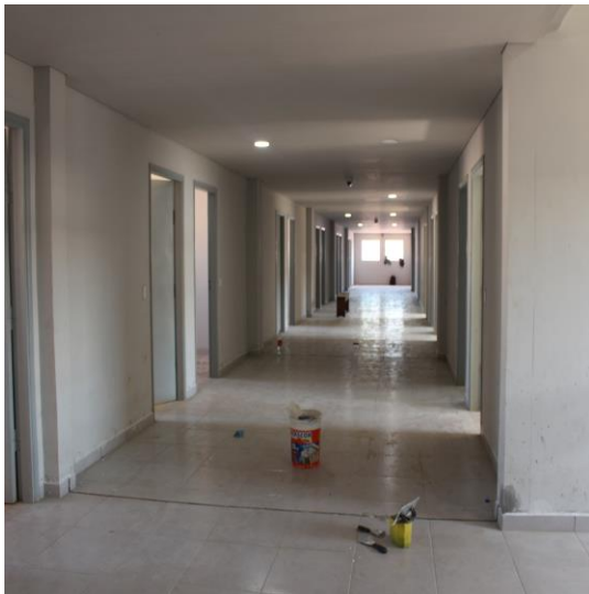
Fotografía 12: Trabajos menores de reparación y cambios.
