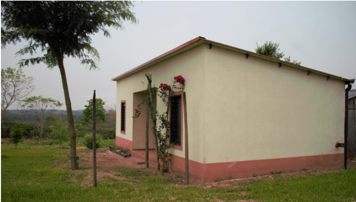
Fotografía N° 4: Fachada lateral frontal de vivienda
