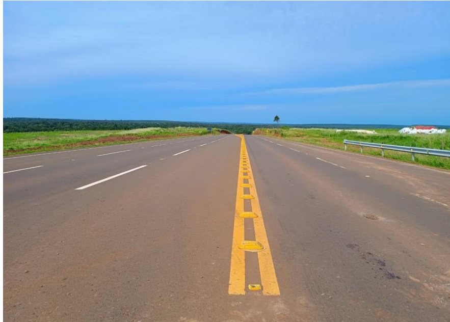
Fotografía N° 8: Acceso a la comunidad indígena de Togue.
