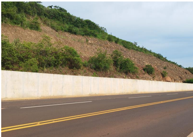
Fotografía N° 6: Muro de contención en la zona de Tembiaporenda.
