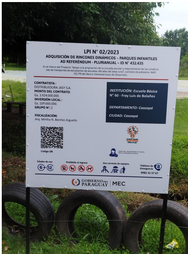
Fotografía N° 1: Cartel de Obras
