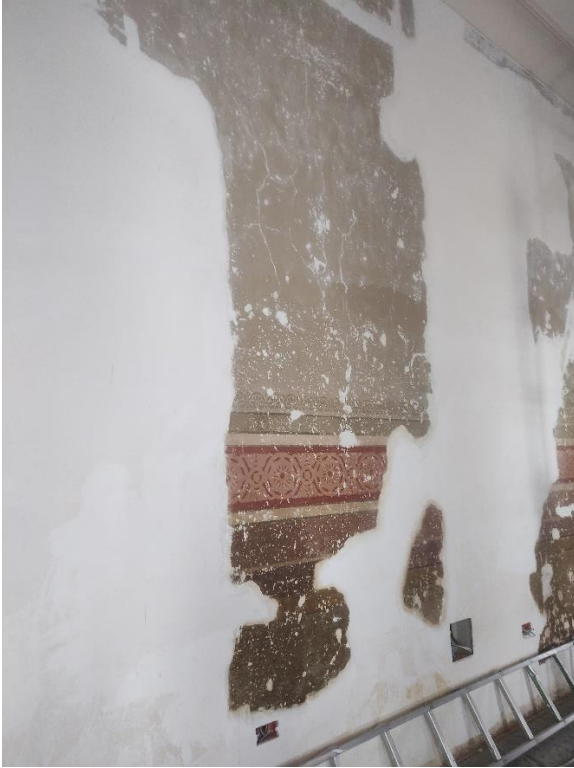
Fotografía N° 8: Remoción de las capas de pintura anteriores.
