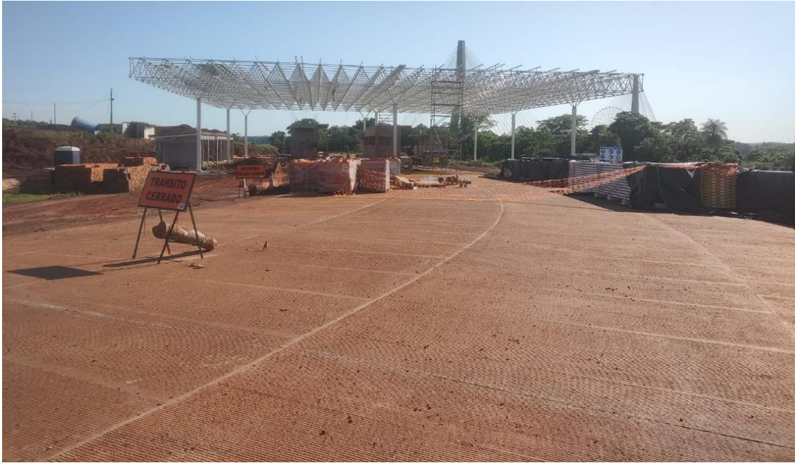
Fotografía N° 3: El acceso al Centro Migratorio construido con pavimento rígido.
