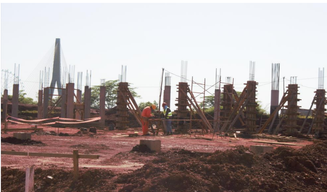
Fotografía N° 6: El trabajo de fundación corresponde específicamente al Edificio de Servicio
