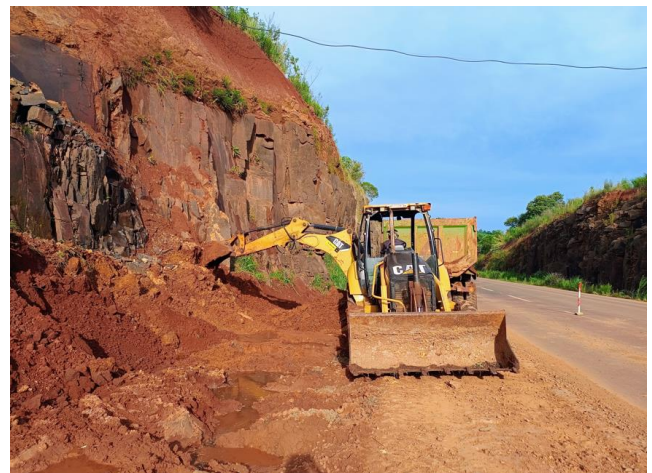
Fotografía N° 7: Remoción de tierras en la serranía de Tembiaporenda.
