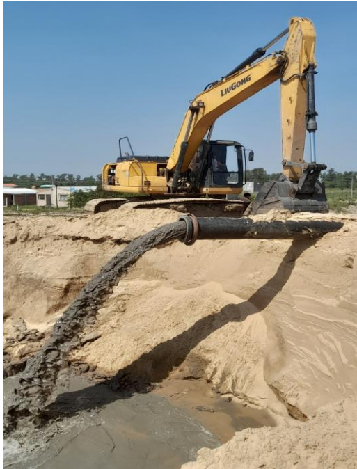
Fotografía N° 19: Trabajos de Refulado Zona Norte
