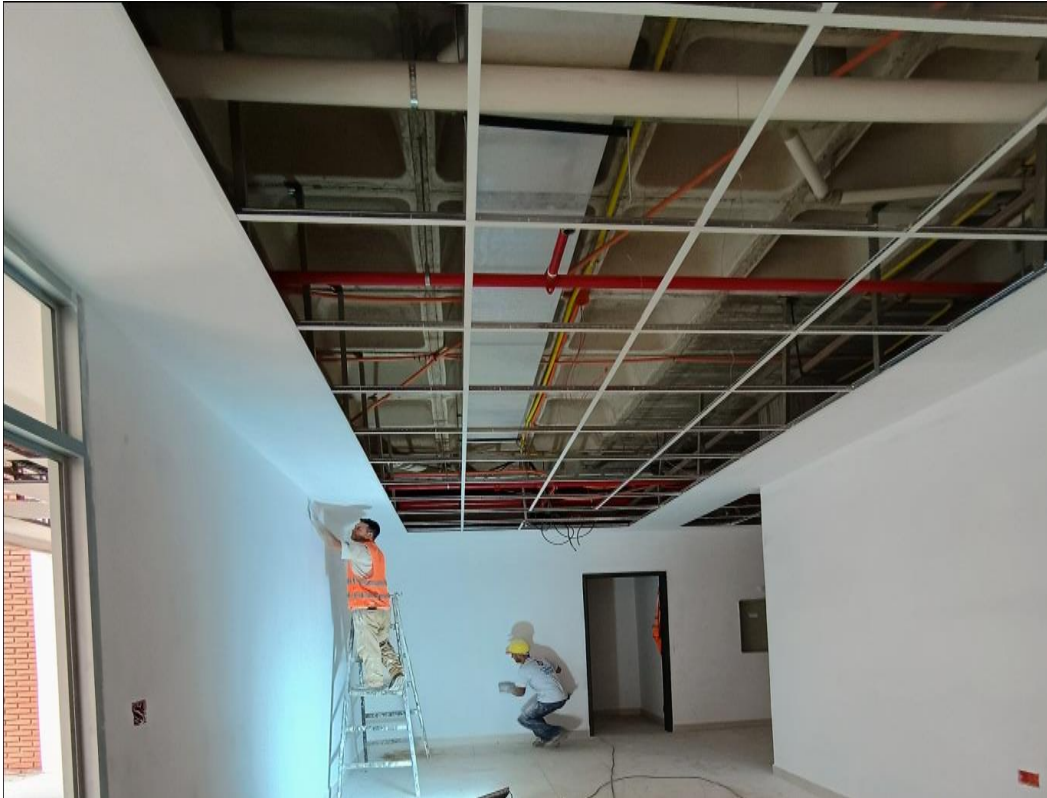
Fotografía N° 5: Instalación de Cielo Rasos
