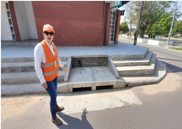
Fotografía N° 11: Desagüe Pluvial Barrio San Antonio.
