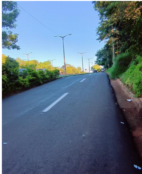
Fotografía N° 11: Colectora en proceso de colocación de señalizaciones verticales y horizontales
