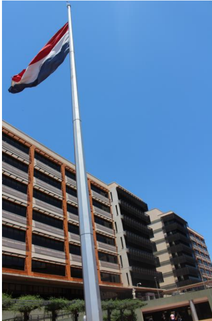
Fotografía N° 15: Parte de la fachada delantera.
