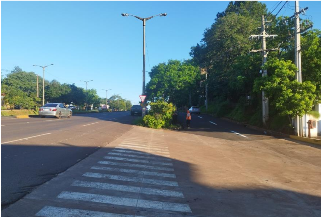
Fotografía N° 10: Construcción de colectora en Quiteria
