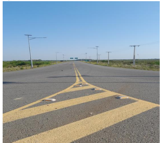
Fotografía N° 22: Acceso al Puerto de Pilar.
