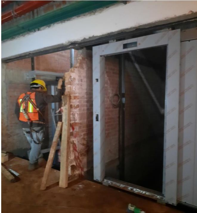
Fotografía N° 13: Preparación de área de ascensores
