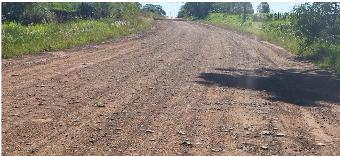
Fotografía N° 2: Inicio de la obra sobre la calle Uruguay (Gral. Artigas – Fram).
