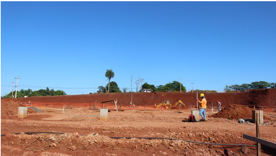
Fotografía N° 4: Vista general de la obra del Centro Migratorio para Turistas
