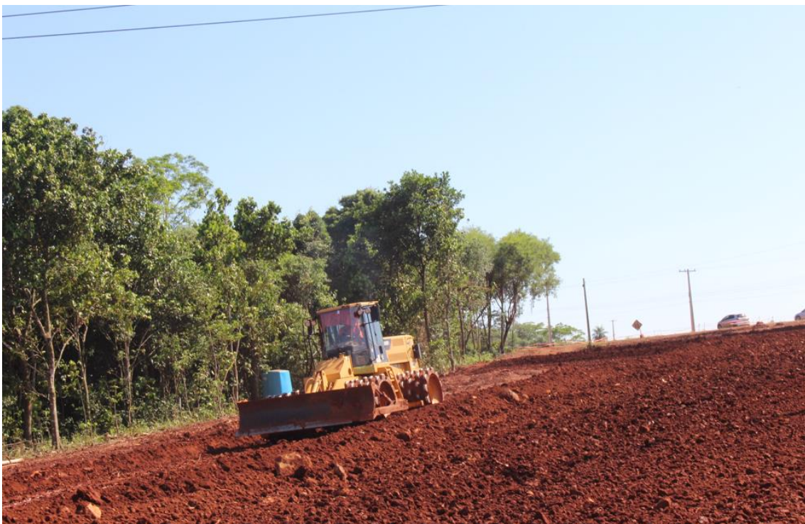
Fotografía N° 3: Movimiento de suelo en accesos urbanos.
