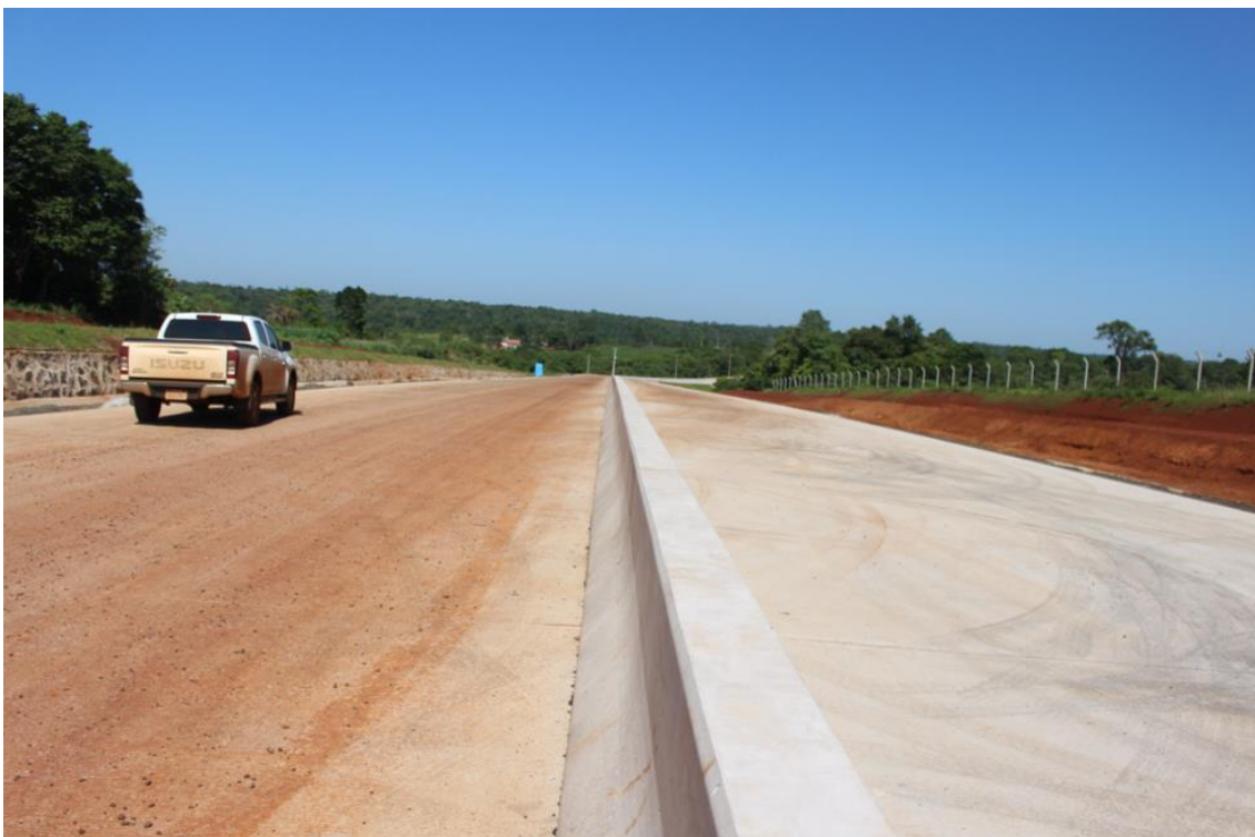
Fotografía N° 5: Construcción de acceso al Puerto ANNP.
