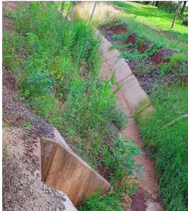
Fotografía N° 2: Malezas que crecen alrededor de banquetas, alcantarillas y cunetas en ciertos puntos.
