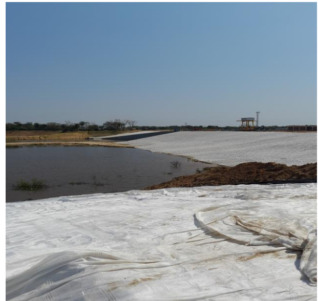
Fotografía N° 18: Vista de obras de sistema de protección de talud
