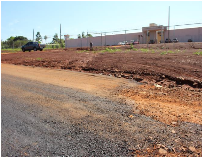
Fotografía N° 3: Final de la capa asfáltica.
