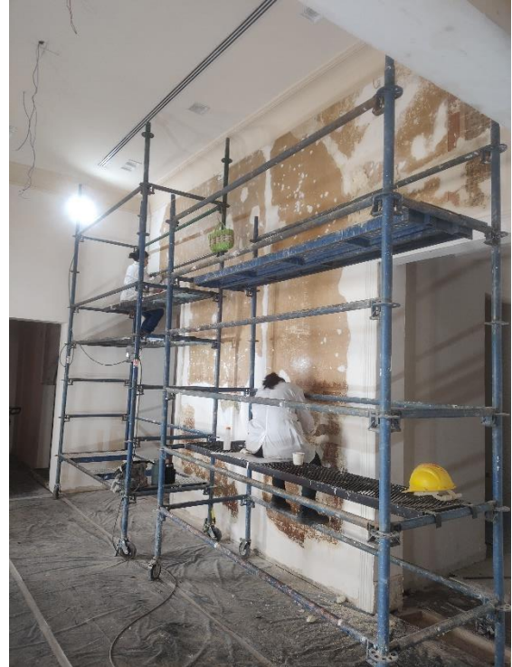
Fotografía N° 9: Expertos realizando el trabajo minucioso de remoción de las capas de pinturas.
