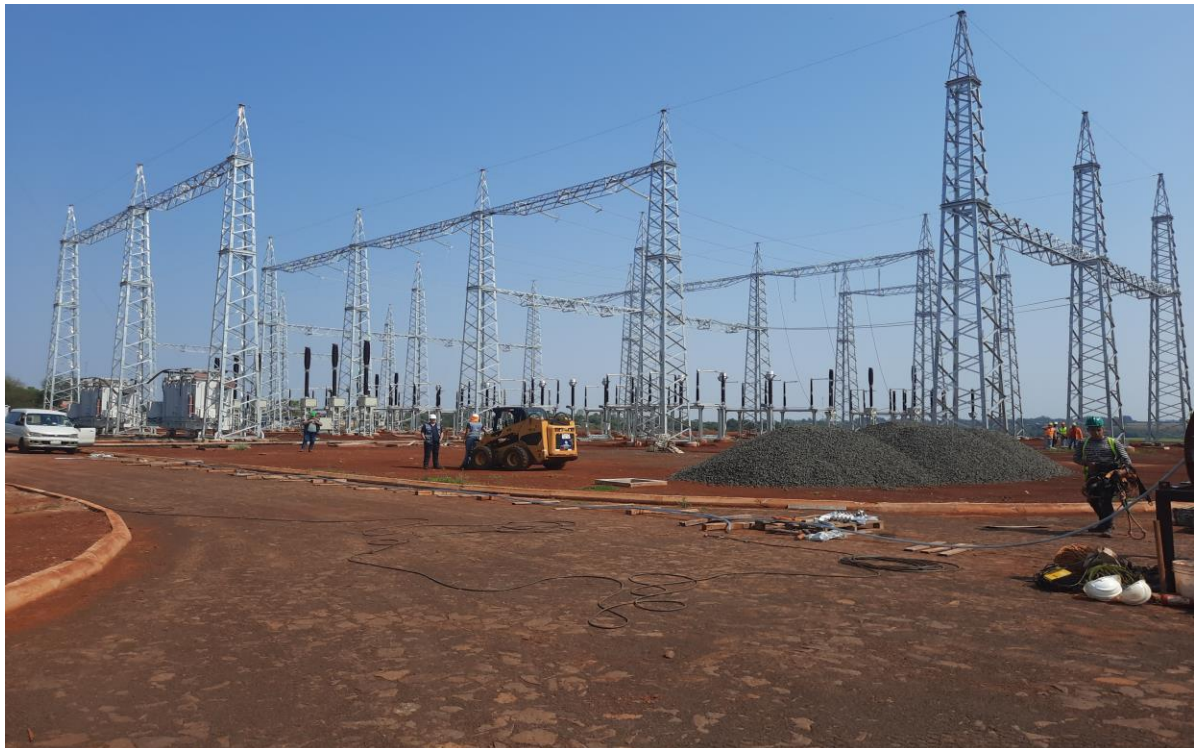
Fotografía N° 3: Vista lateral de Subestación, torres en proceso de montaje
