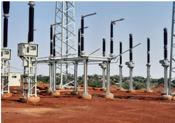
Fotografía N° 5: Montaje de barras
