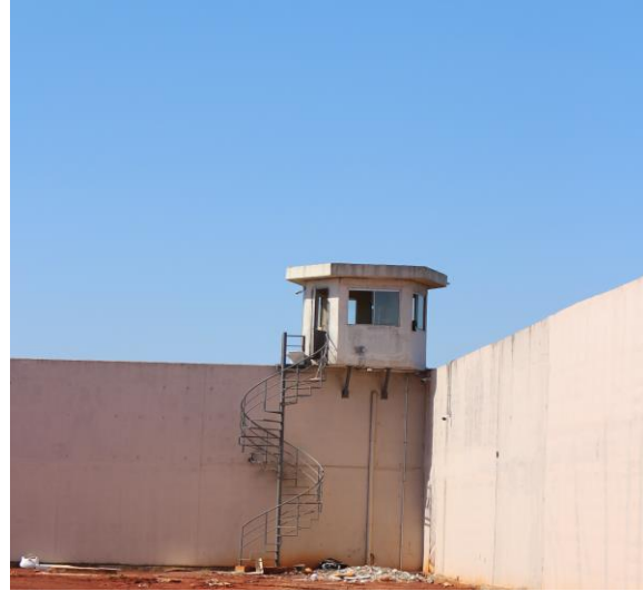
Fotografía 12: Garitas de control sobre vallado perimetral exterior del recinto penitenciario.
