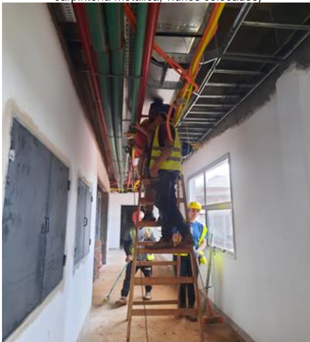
Fotografía N° 11: Instalaciones eléctricas y de señales en proceso
