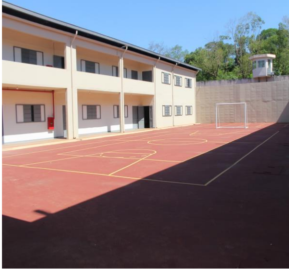
Fotografía 7: Area de patio (canchas) finalizada.
