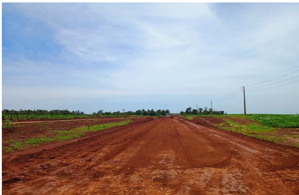
Fotografía N° 3: Compactación del terraplenado en otro punto de Kressburgo
