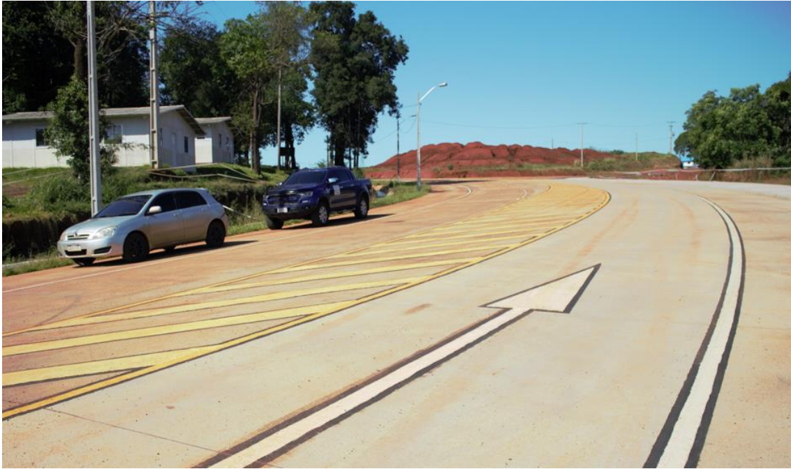
Fotografía N° 2: Señalizaciones del acceso al Segundo Puente.
