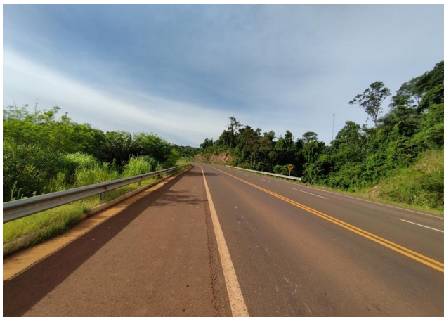
Fotografía N° 3: Estado de la ruta con la intervención ejecutada.
