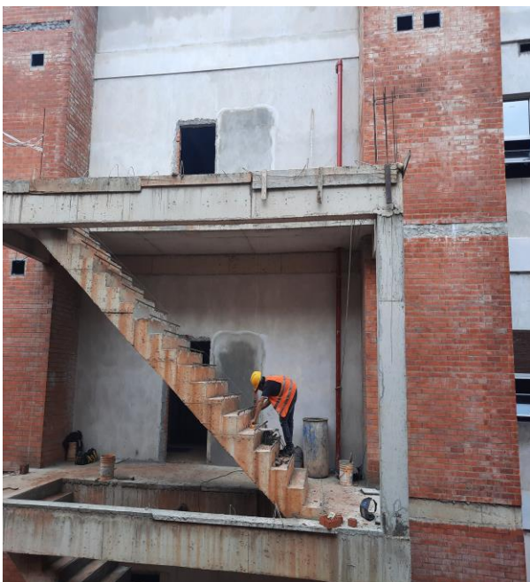
Fotografía N° 5: Colocación de zócalos en escaleras
