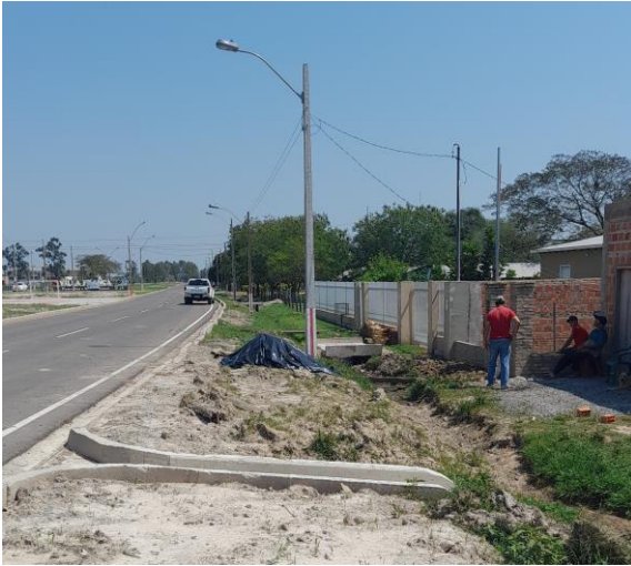
Fotografía N° 7: Canaleta zona urbana de Villa Franca.
