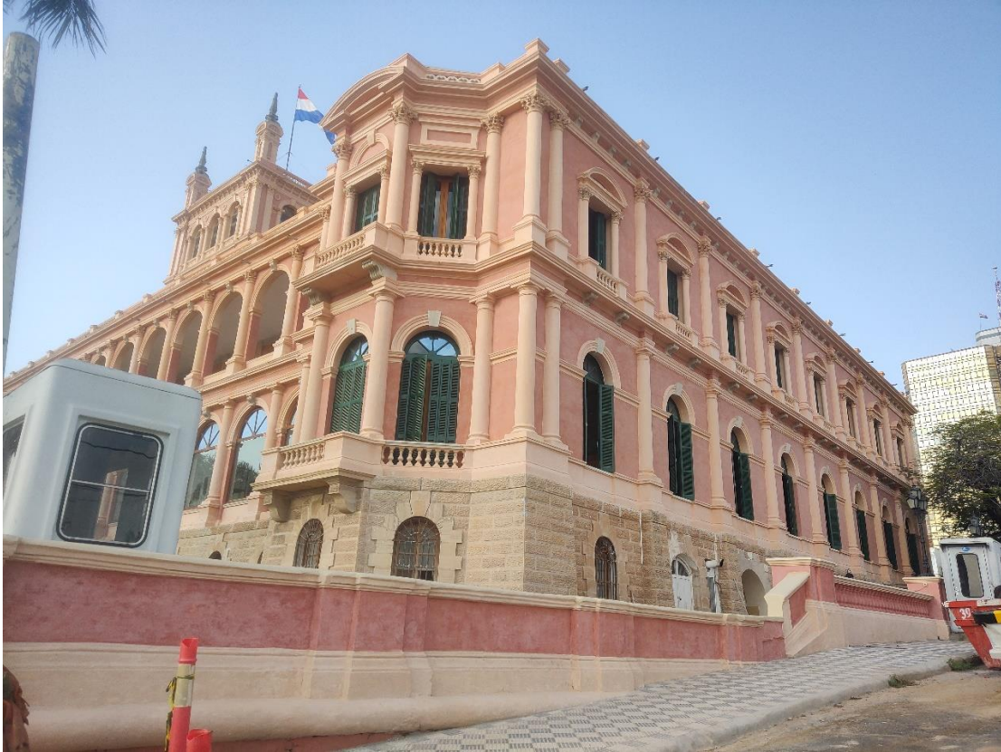
Fotografía N° 1: Fachada actual del ala oeste del Palacio de Gobierno con vista al río Paraguay.
