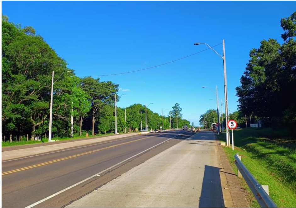
Fotografía N° 1: Señalizaciones y franja de dominio en buenas condiciones a lo largo del tramo
