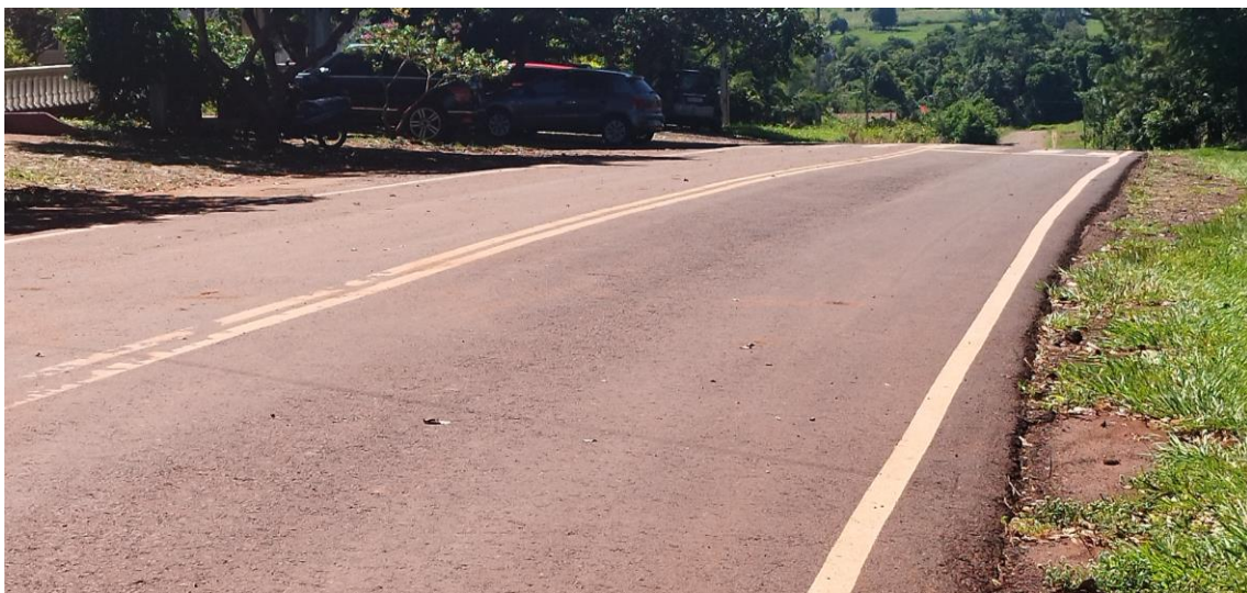
Fotografía N° 1: Pavimentación asfáltica complementaria para el acceso a la Unidad de Servicio Familiar - La Paz
