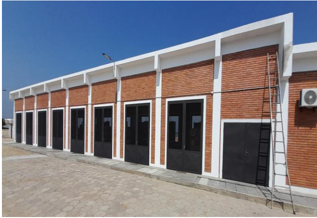
Fotografía N° 15: Salas estación de bombeo Ñeembucú
