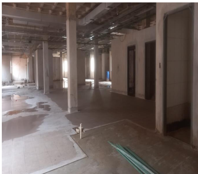
Fotografía N° 3: Pisos en proceso de colocación
