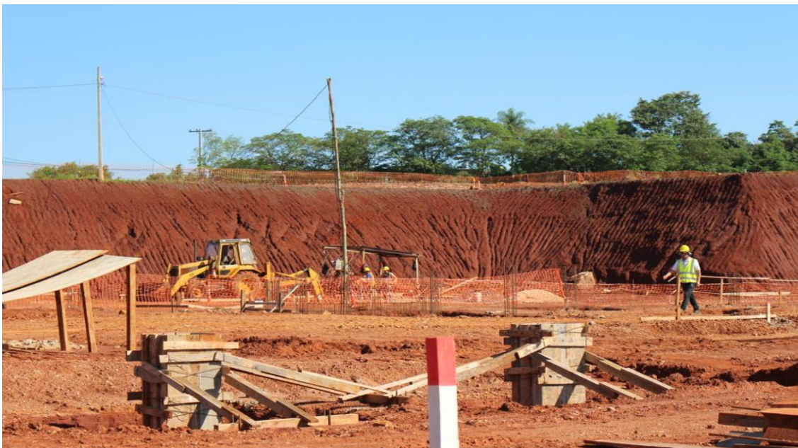
Fotografía N° 5: Trabajo de fundaciones para los diferentes edificios que se construirán en el lugar del Centro Migratorio para Turistas
