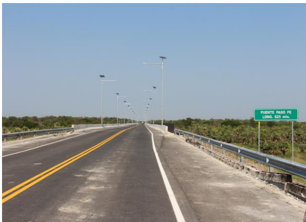
Fotografía N° 5: Puente sobre el arroyo Paso Pe con iluminación con paneles solares.
