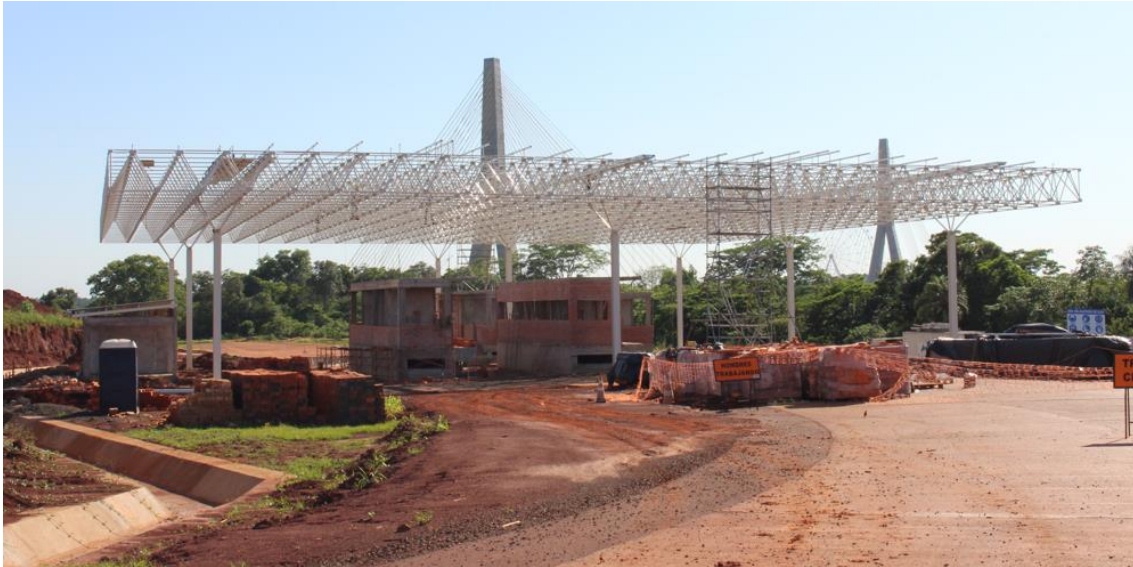
Fotografía N° 1: Vista general de la obra del Centro Migratorio para cargas pesadas
