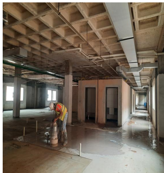
Fotografía N° 4: Pulido de pisos
