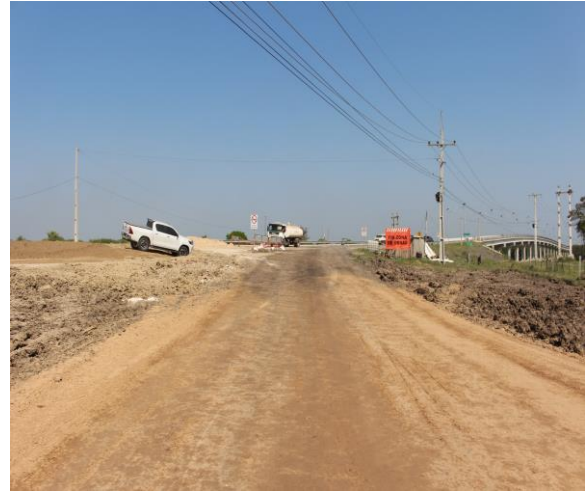
Fotografía Nº 14: Unión de las Obras 1 y 2 del proyecto.
