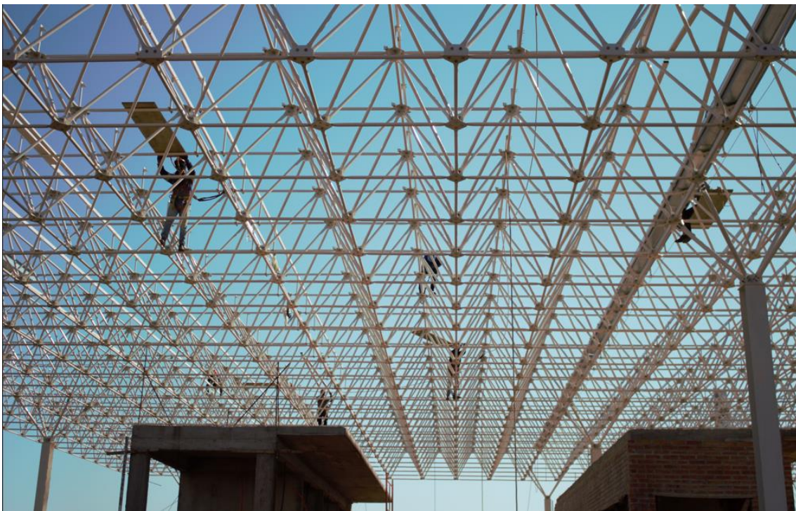
Fotografía N° 2: Actualmente en ejecución el montaje de la estructura metálica del techo para el futuro Centro Migratorio de cargas pesadas.
