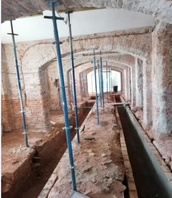
Fotografía N° 4: Aspecto del pasillo en el subsuelo en la visita técnica del 2021.
