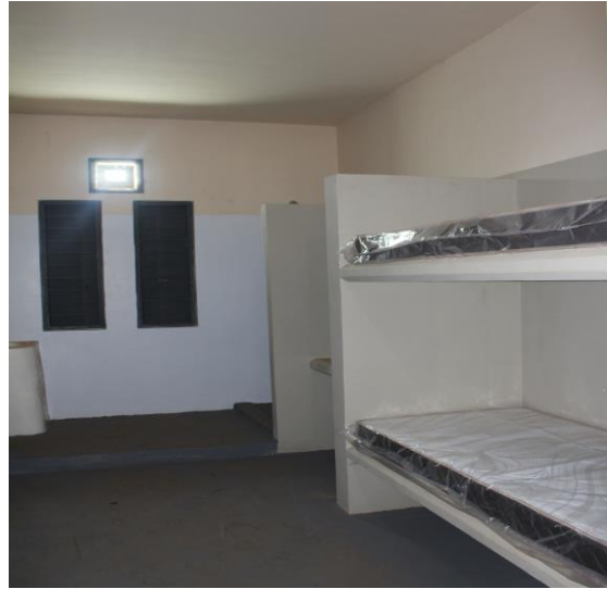
Fotografía 8: Pabellones de celdas y celdas finalizadas.
