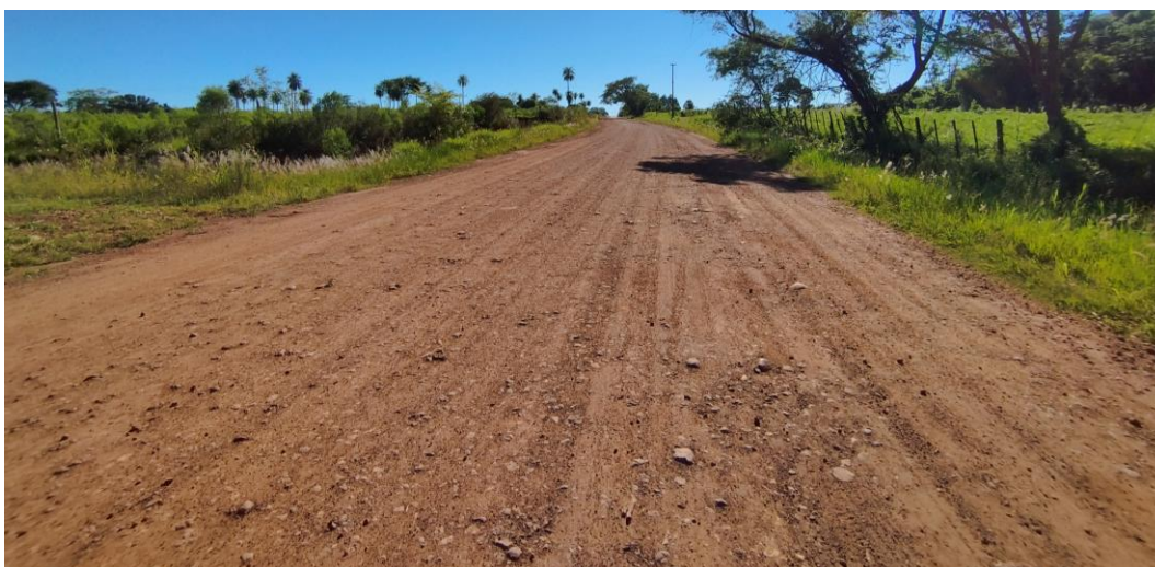
Fotografía N° 3: Tramo de terraplén compactada
