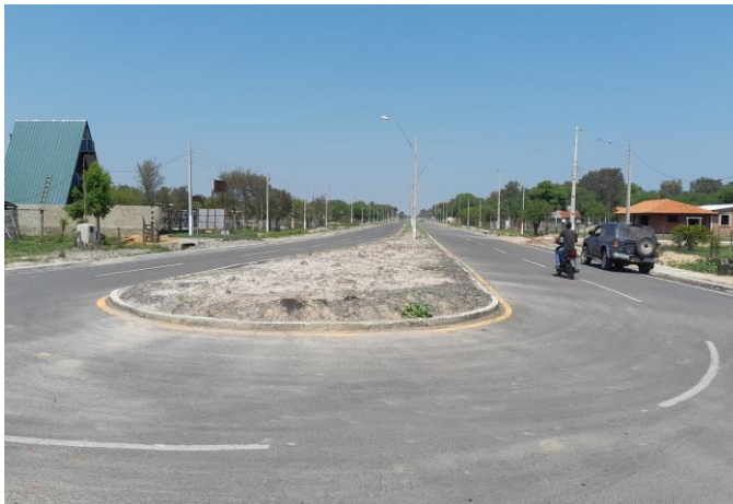
Fotografía N° 9: Doble avenida en Villa Franca.
