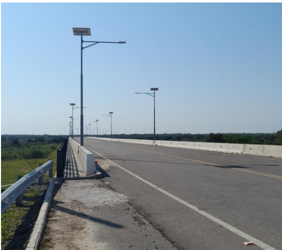
Fotografía Nº 17: Vista de estado actual del puente sobre el Arrollo Yacaré.
