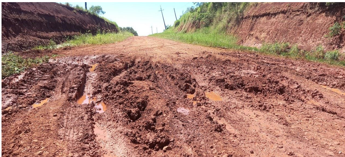
Fotografía N° 5: Tramos en mal estado por causa de las nacientes
