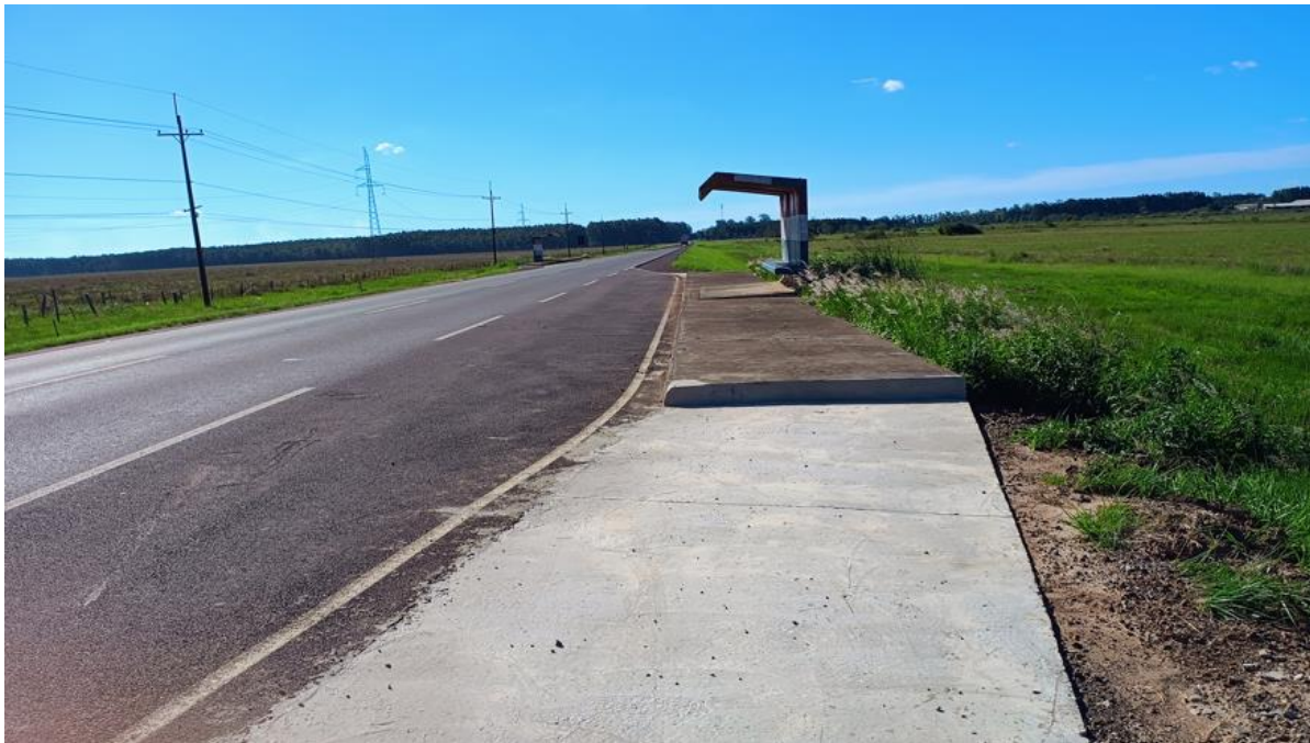
Fotografía N° 7: Dársenas con refugio para peatones de hormigón armado.
