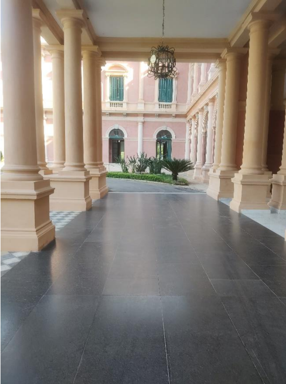
Fotografía N° 12: Piso de granito colocado en la entrada principal de la planta baja del edificio, fue incluido en el convenio modificatorio
