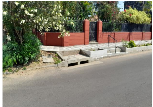
Fotografía N° 12: Veredas construidas y boca de tormenta
