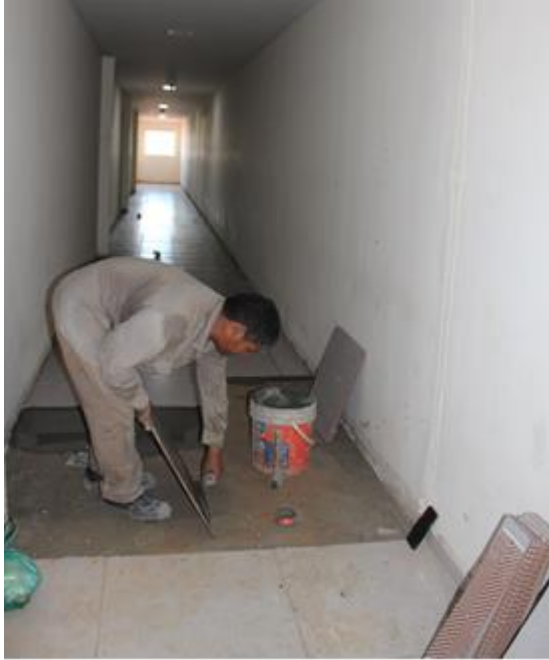
Fotografía 3: Obrero cambiando pisos en mal estado
