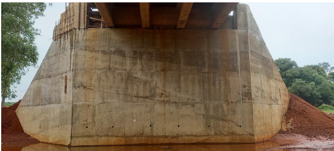
Fotografía N° 1: Estribo del puente en construcción.
