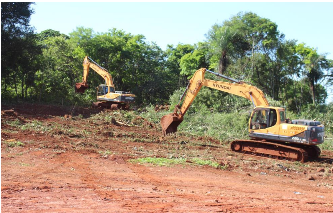
Fotografía N° 4: Desbroce de árboles para la construcción del acceso y un puente sobre el río Monday.
