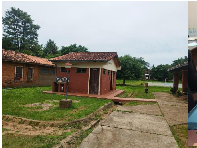
Fotografía N° 2: Fachada de sanitario
