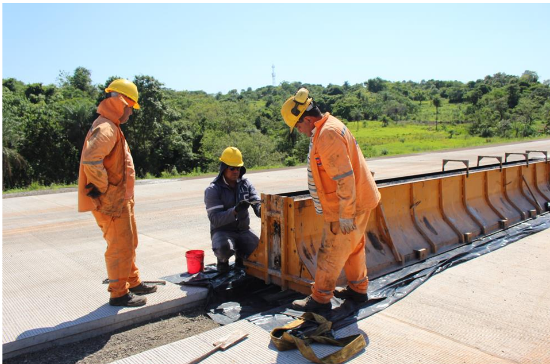
Fotografía N° 6: Colocación de cordones (New Jersey) en el acceso al Puerto de la ANNP.
