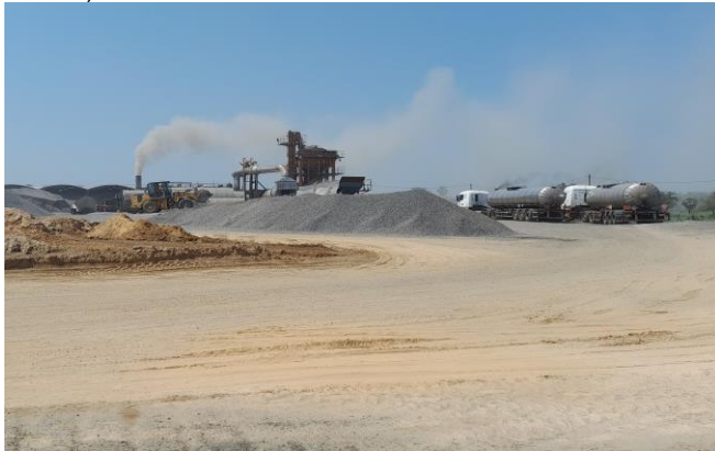
Fotografía N° 3: Planta asfáltica de la empresa contratista.
