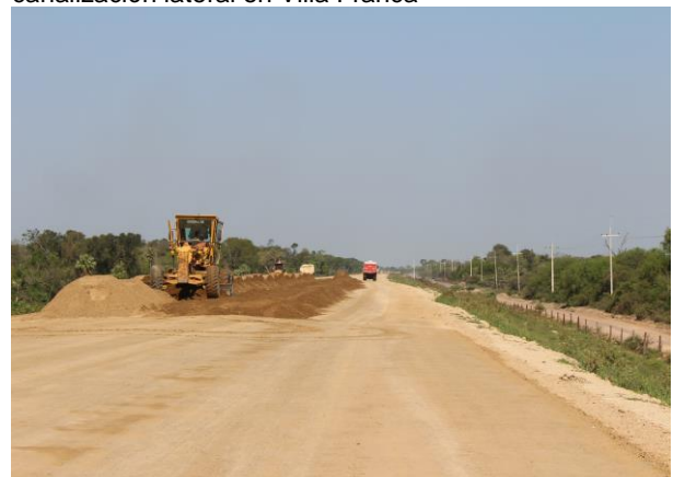
Fotografía N° 12: Trabajos de capas de suelo.
