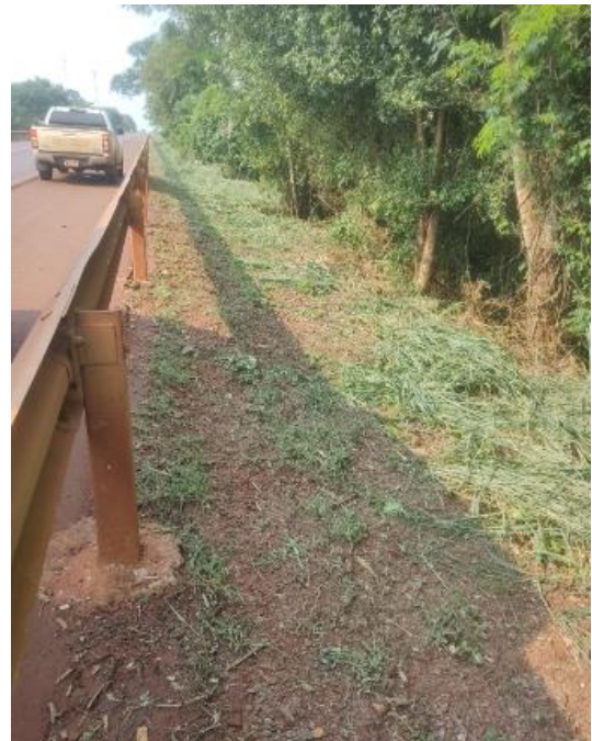
Fotografía N° 7: Limpieza de franja de dominio km antes de llegar a Cruce Carolina.
