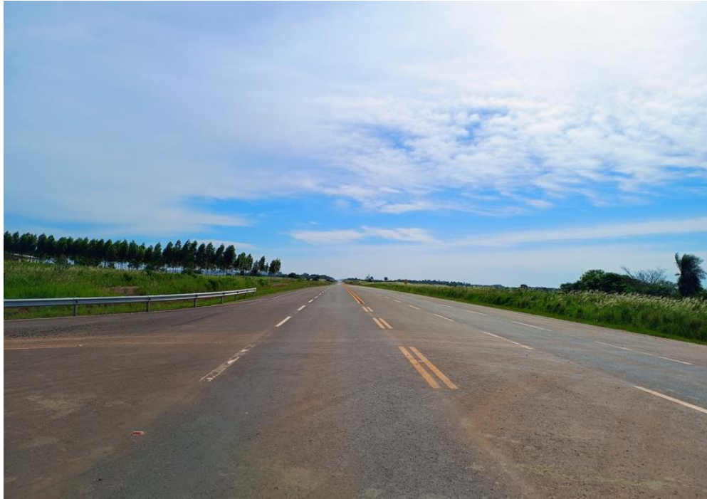
Fotografía N° 2: Estado del tramo intervenido sobre la Ruta PY N° 18.
