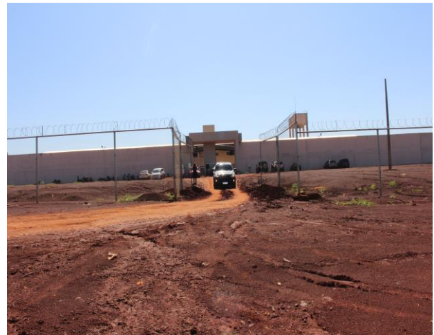
Fotografía N° 4: Vallada perimetral en el ingreso al penal
