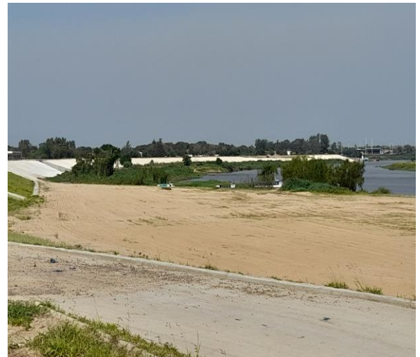
Fotografía N° 14: Vista del muro de defensa con sistemas de protección
