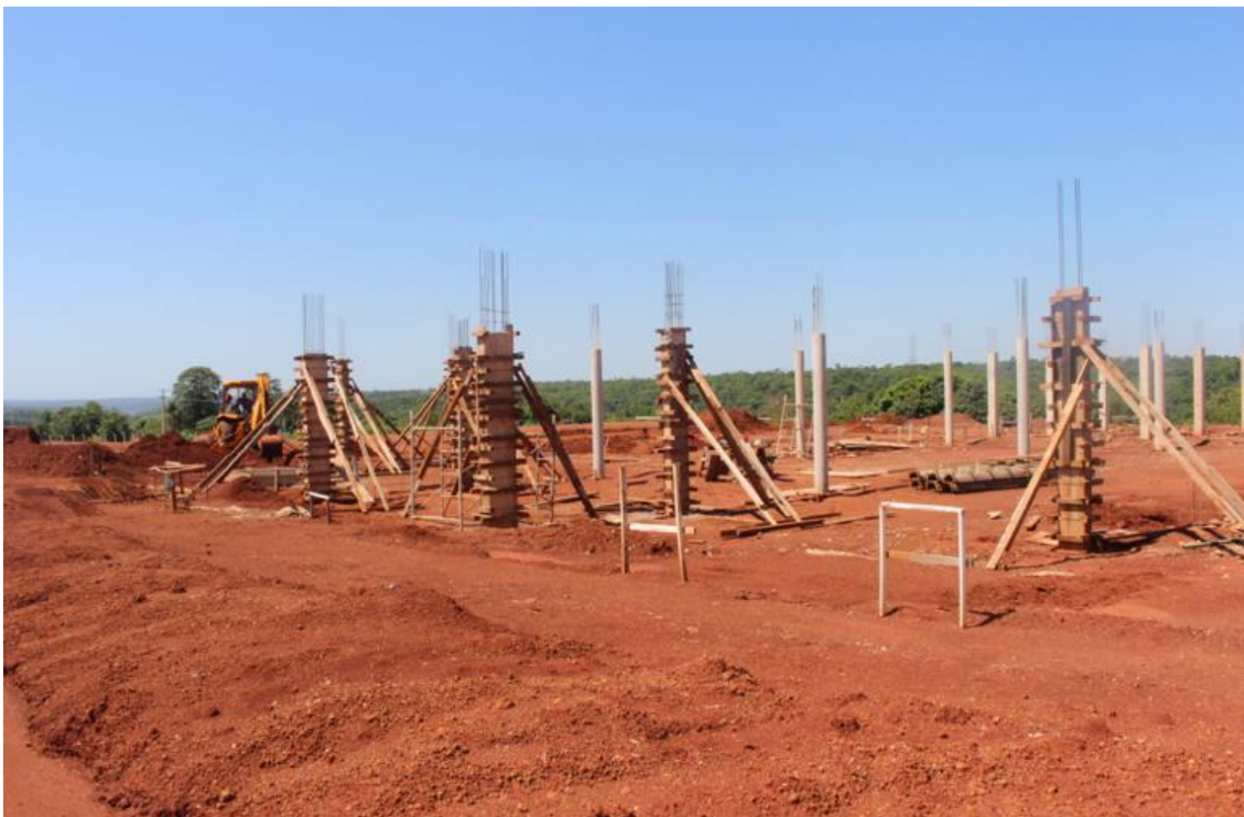
Fotografía N° 2: Etapa de movimiento de suelo y elevación de pilotes para el futuro depósito
