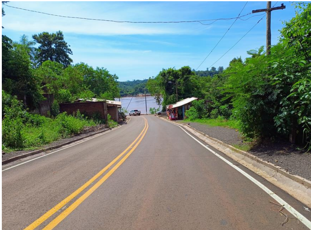
Fotografía N° 2: Llegando al final del acceso, cunetas en buen estado y las señalizaciones también
