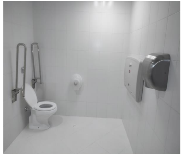
Fotografía N° 18: Servicio de Sanitarios inclusivos.
