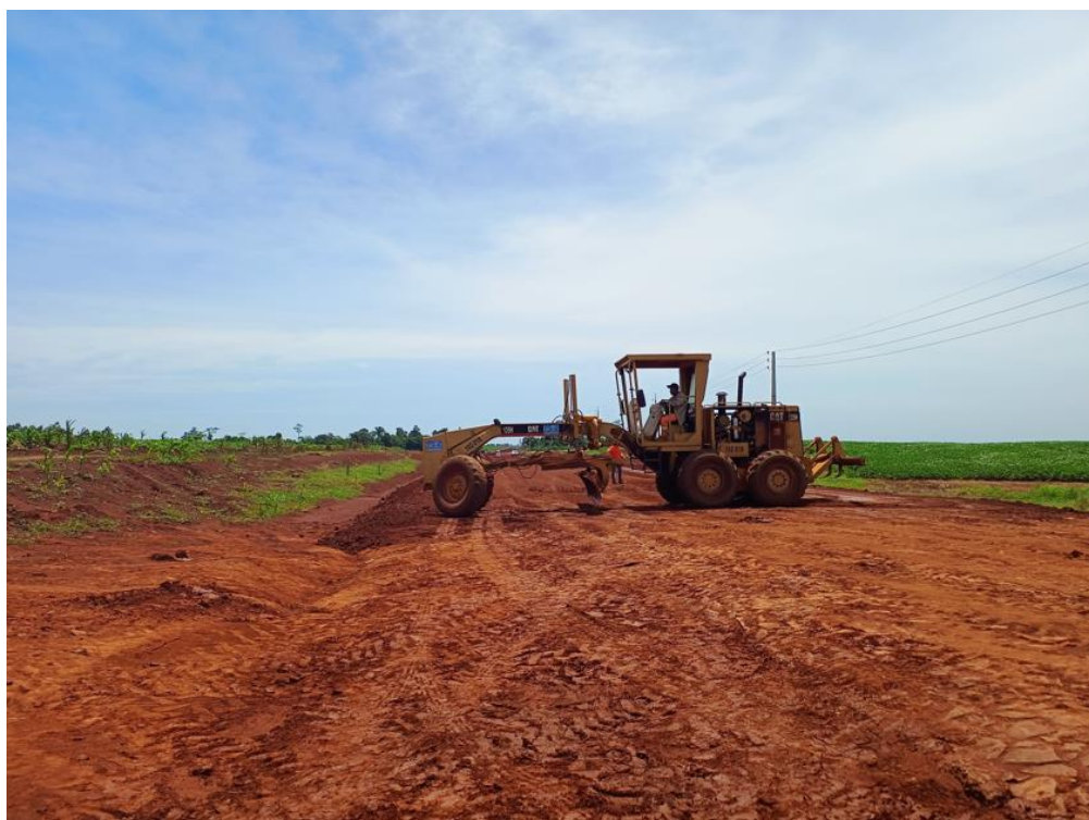
Fotografía N° 2: Movimiento de suelo en la zona de Kressburgo
