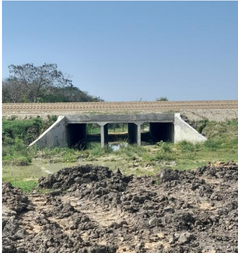
Fotografía Nº 13: Obras de alcantarilla tramo en construcción
