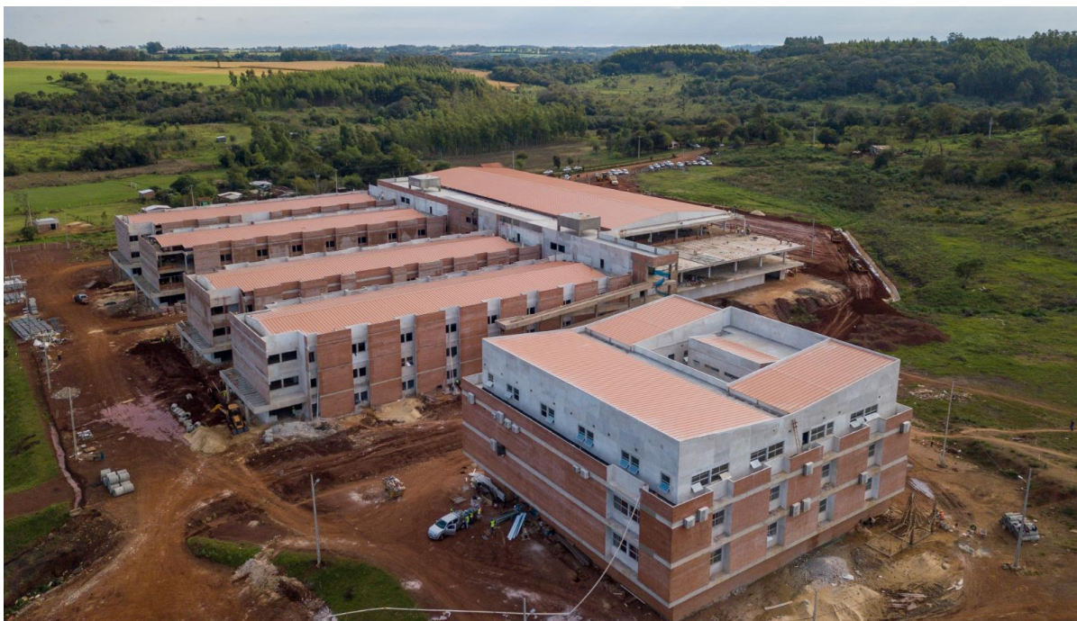
Fotografía N° 2: Vista aérea del Hospital Regional de Encarnación – techos colocados
