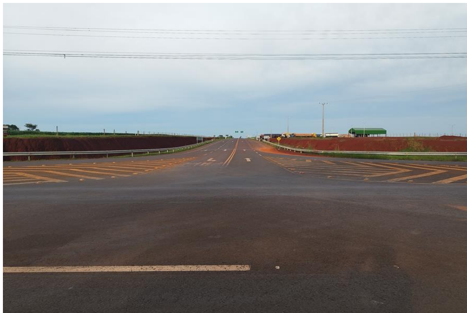
Fotografía N° 1: Inicio del recorrido de la obra en la intersección de la Ruta PY 6 con la PY 18.
