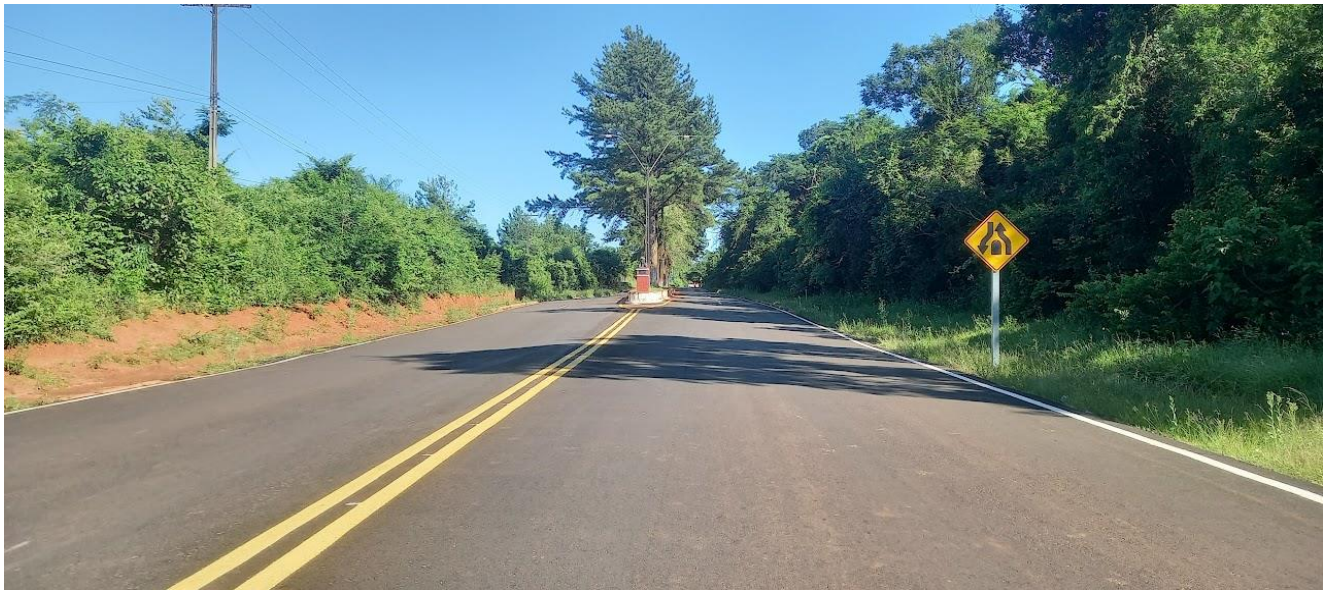
Fotografía N° 1: Pavimentación asfáltica complementaria, acceso a Gral. Artigas.
