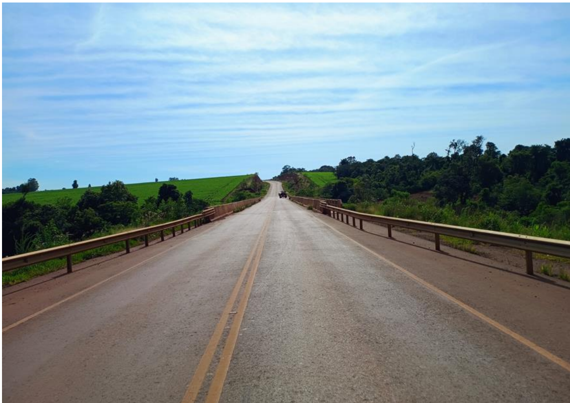
Fotografía N° 5: Puente sobre el Río Tembey
