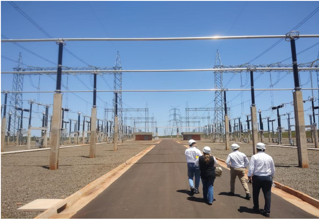
Fotografía N° 3: Recorrido de monitoreo en zona de obras concluidas
