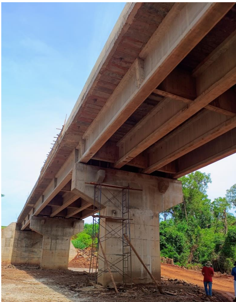
Fotografía N° 5: Pilotes y vigas del puente.
