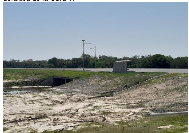
Fotografía N° 6: Alcantarilla zona Villa Franca y caseta para pasajeros.
