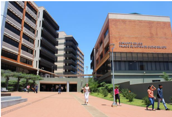
Fotografía Nº 1: Fachada complejo edilicio sede Poder Judicial de Ciudad del Este.
