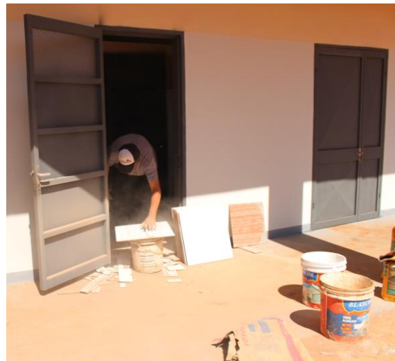
Fotografía 6: Trabajos menores de terminación de baños del área de Talleres.
