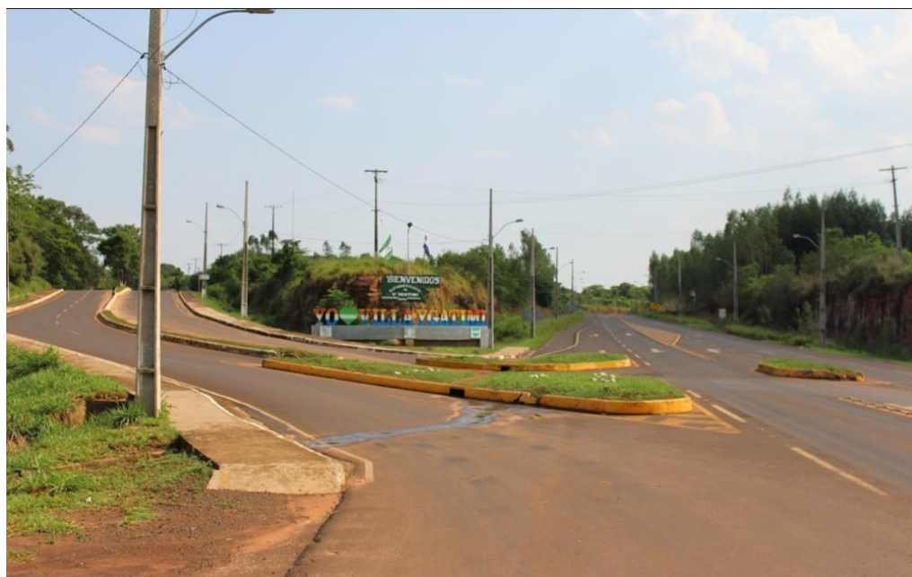
Fotografía N° 4: En buen estado el acceso a la ciudad de Villa Ygatimí
