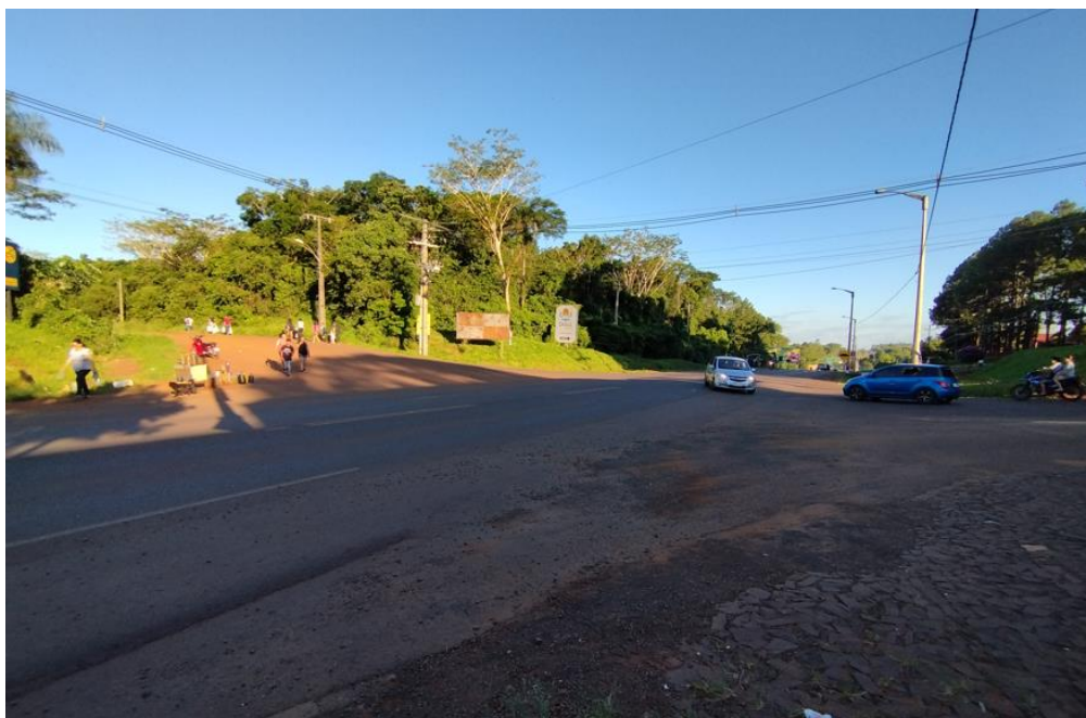
Fotografía N° 8: Intersección donde se produce muchos accidentes frente al Colegio Militar
