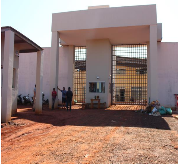
Fotografía 11: Portal de acceso finalizado con portones instalados y puesto de guardia y control de ingreso.
