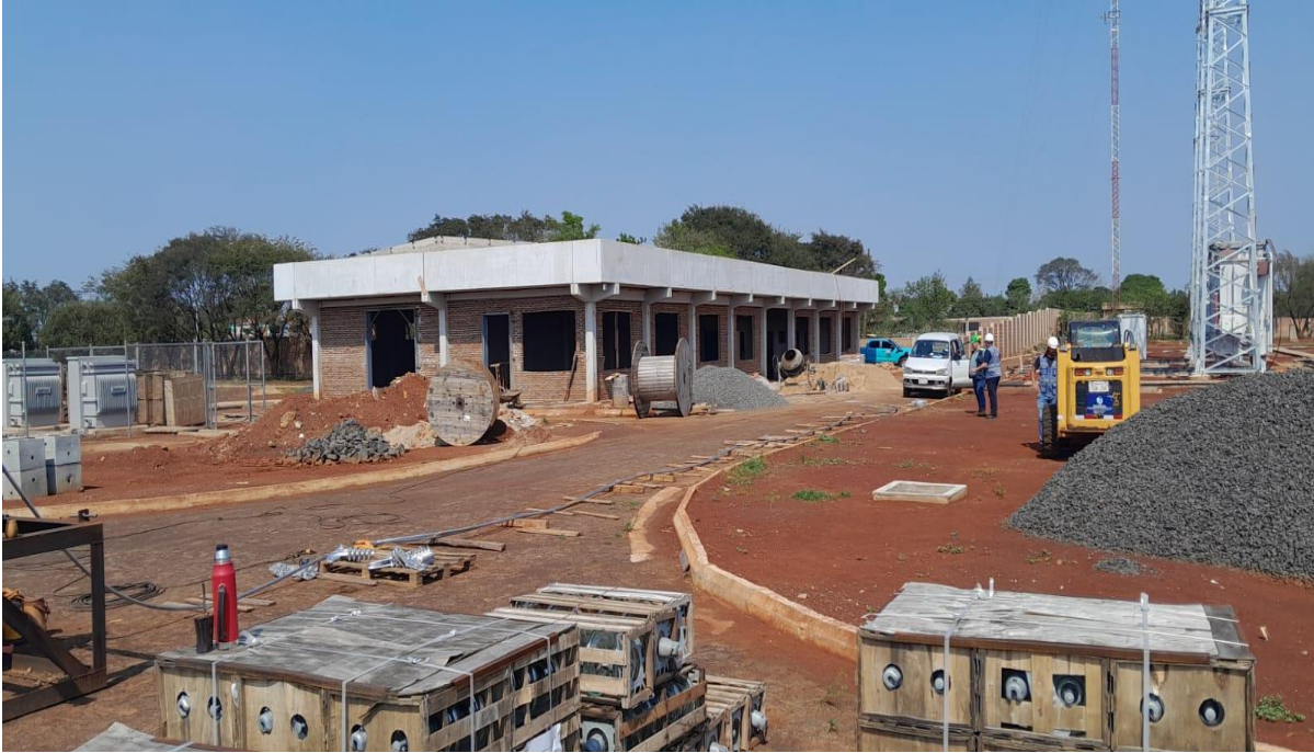
Fotografía N° 2: Casa de Control en construcción
