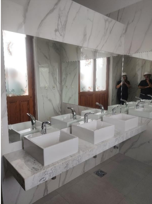
Fotografía N° 15: Los baños del primer piso completamente restaurados.
