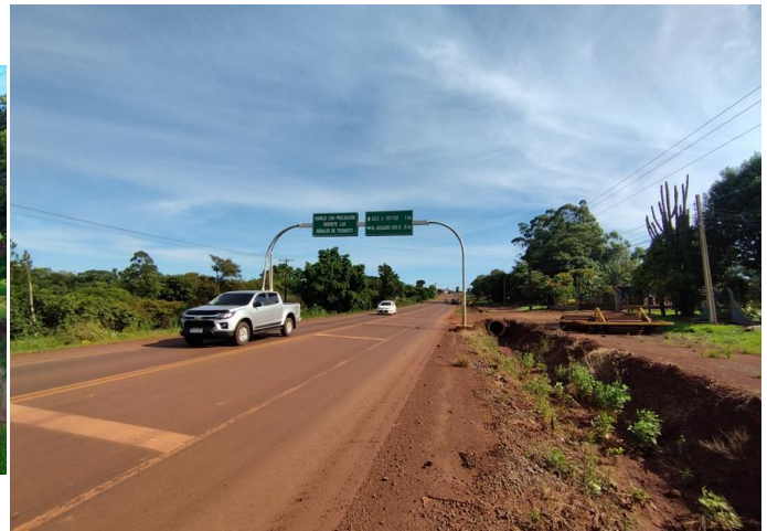
Fotografía N° 4: Acceso a de Yatytay
