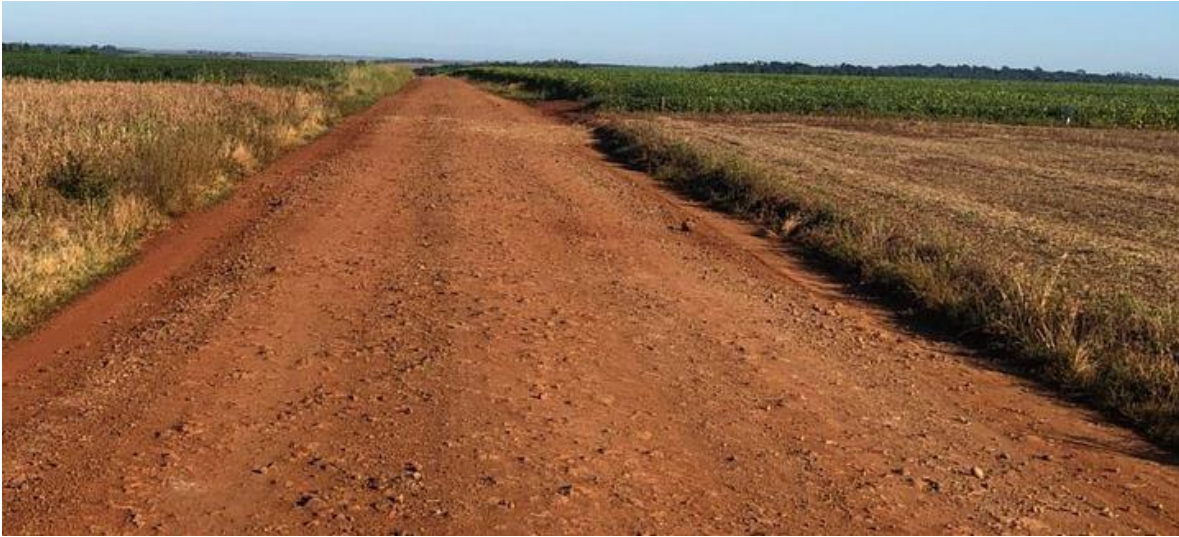
Fotografía N° 5: Terraplén en buen estado
