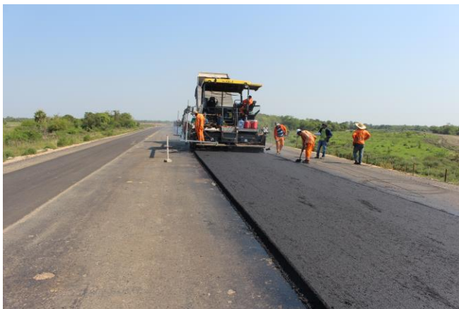
Fotografía N° 11: Trabajos de pavimentación asfáltica.
