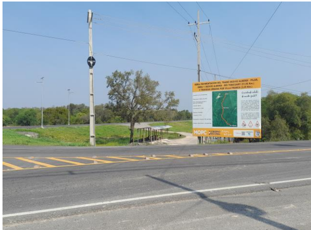
Fotografía N° 1: Cartel en el inicio de la obra (Desvío Alberdi)
