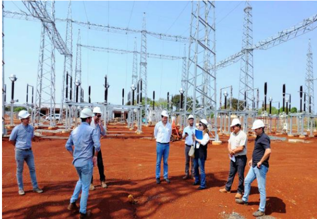
Fotografía N° 7: Recorrido de monitoreo en zona de obras
