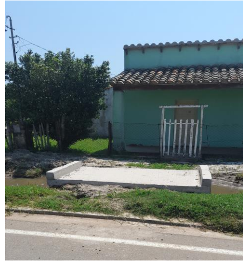
Fotografía N° 8: Trabajos de losa acceso a viviendas.
