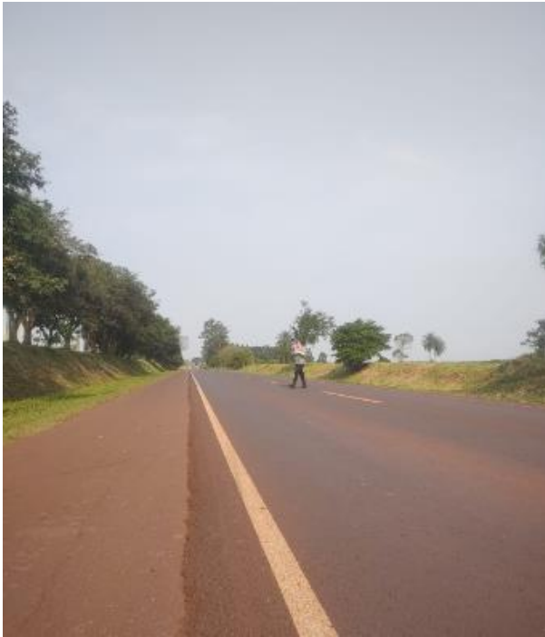
Fotografía N° 3: El trabajo de rehabilitación está terminado
