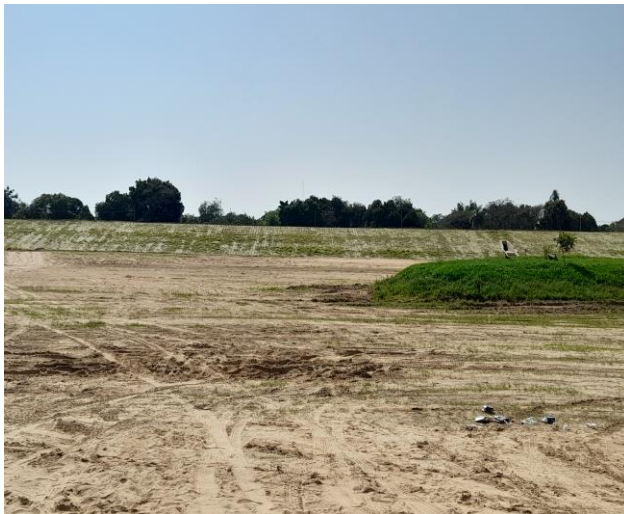
Fotografía N° 13: Muro de defensa con vista desde la zona de playa
