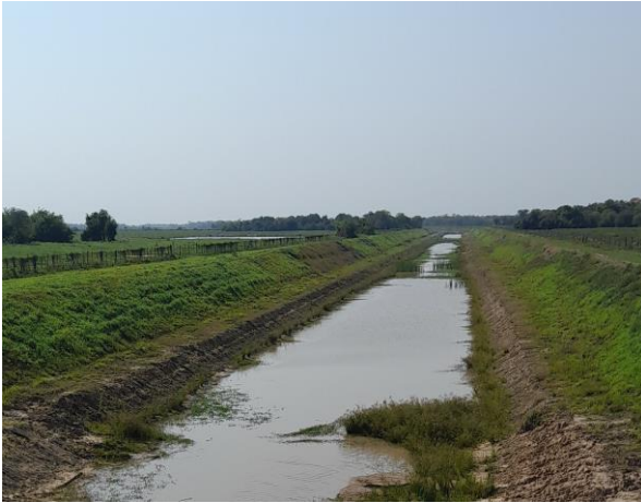
Fotografía N° 9: Canal de Derivación San Lorenzo
