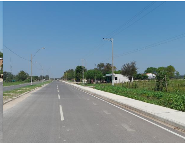
Fotografía N° 10: Pavimentación asfáltica y canalización lateral en Villa Franca
