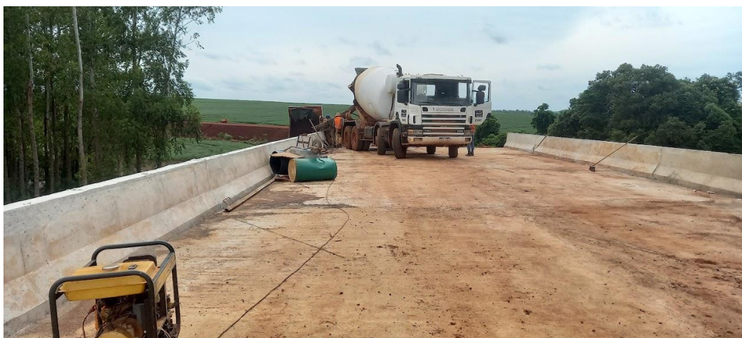
Fotografía N° 4: Parte del puente culminado.
