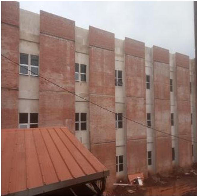
Fotografía N° 9: Vista lateral de un bloque (mampostería, carpintería metálica, vidrios colocados)
