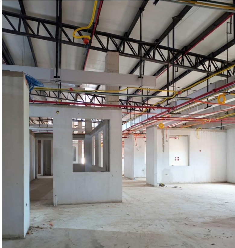
Fotografía N° 3: Zona de futuros consultorios
