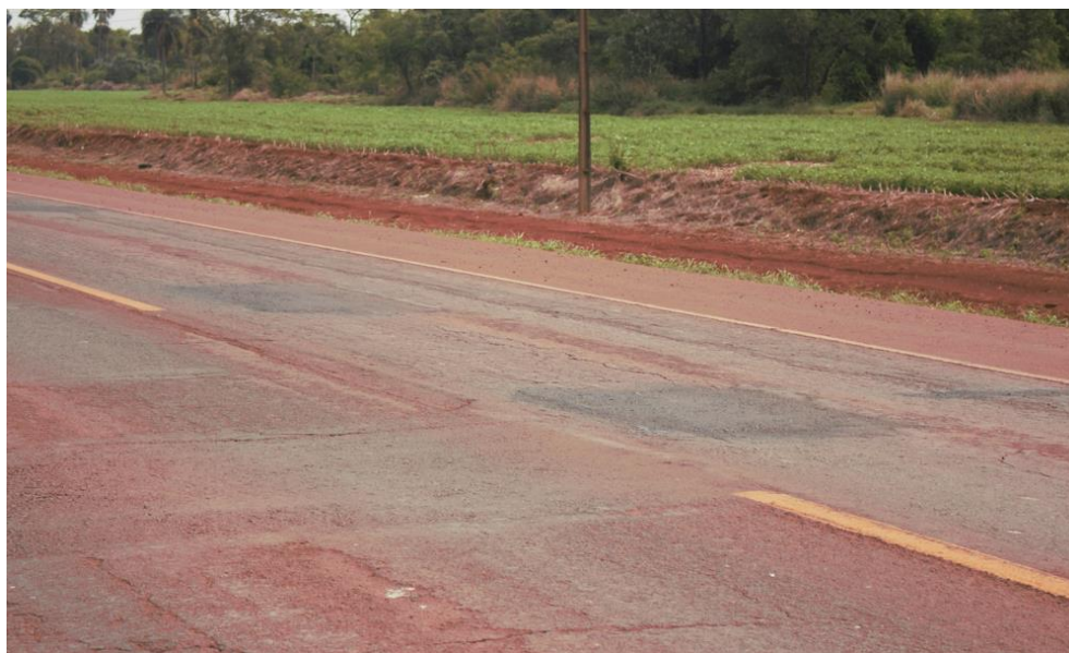
Fotografía N° 10: Estado actual de las rutas donde se realizaron las intervenciones de bacheo, sellado de fisuras, también se ha verificado la franja de dominio limpia.
