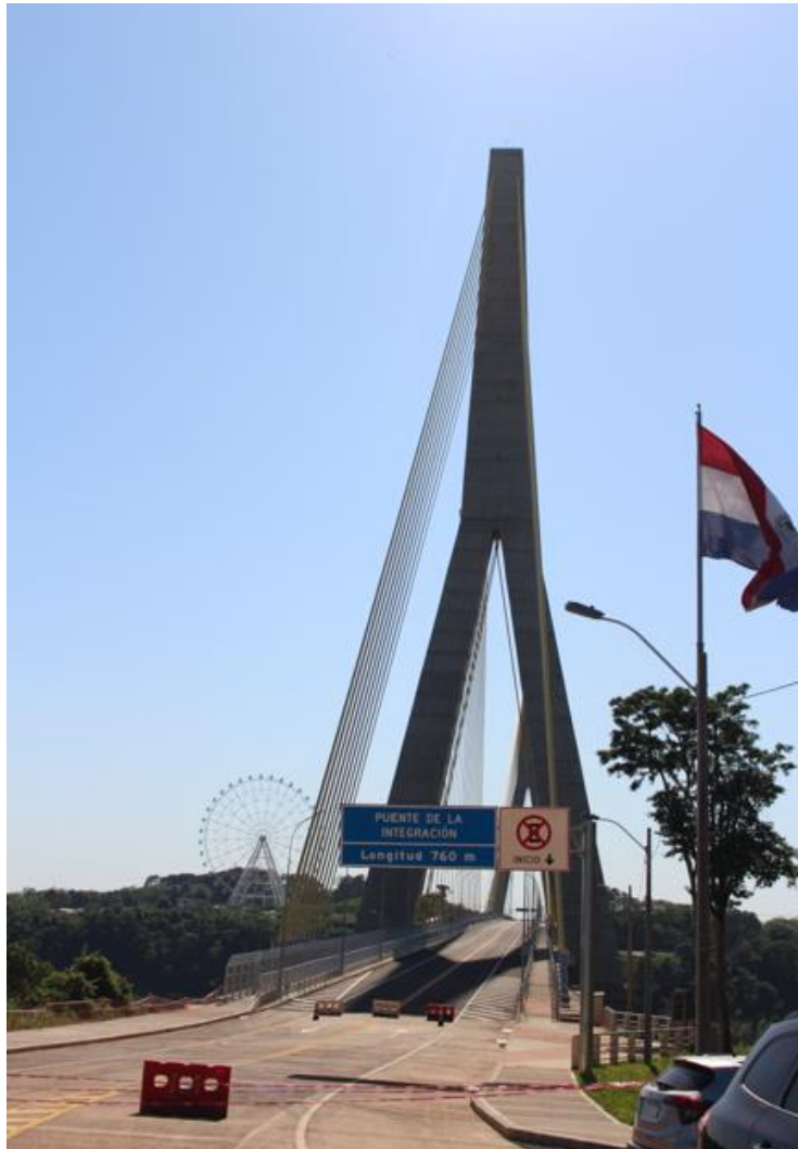
Fotografía N° 1: Acceso al 2do. Puente construido con pavimento rígido.
