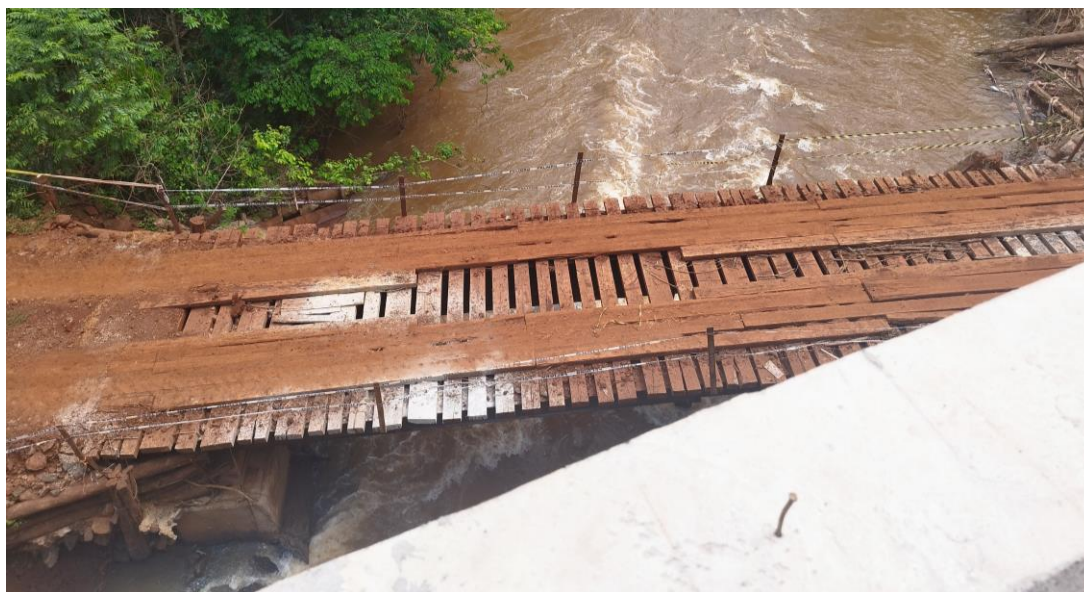
Fotografía N° 6: Puente provisorio sobre el Río Ñacunday
