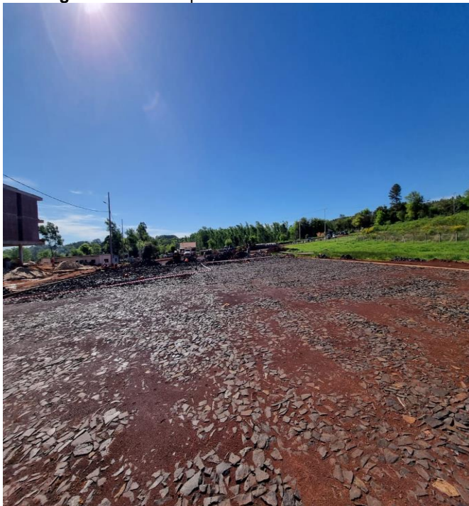
Fotografía N° 15: Empedrados en el área de estacionamiento, en construcción
