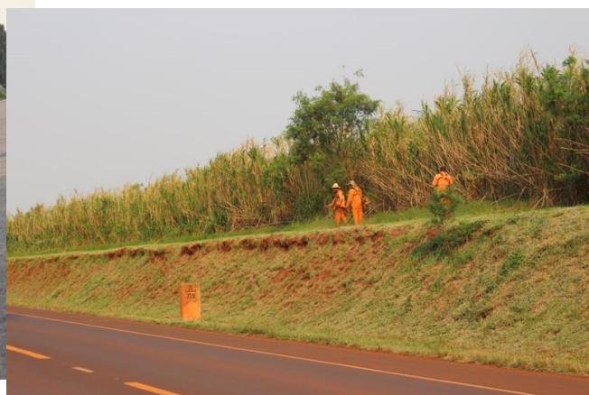
Fotografía N° 2: Limpieza de banquina y franja de dominio a lo largo de la Ruta N° 10.
