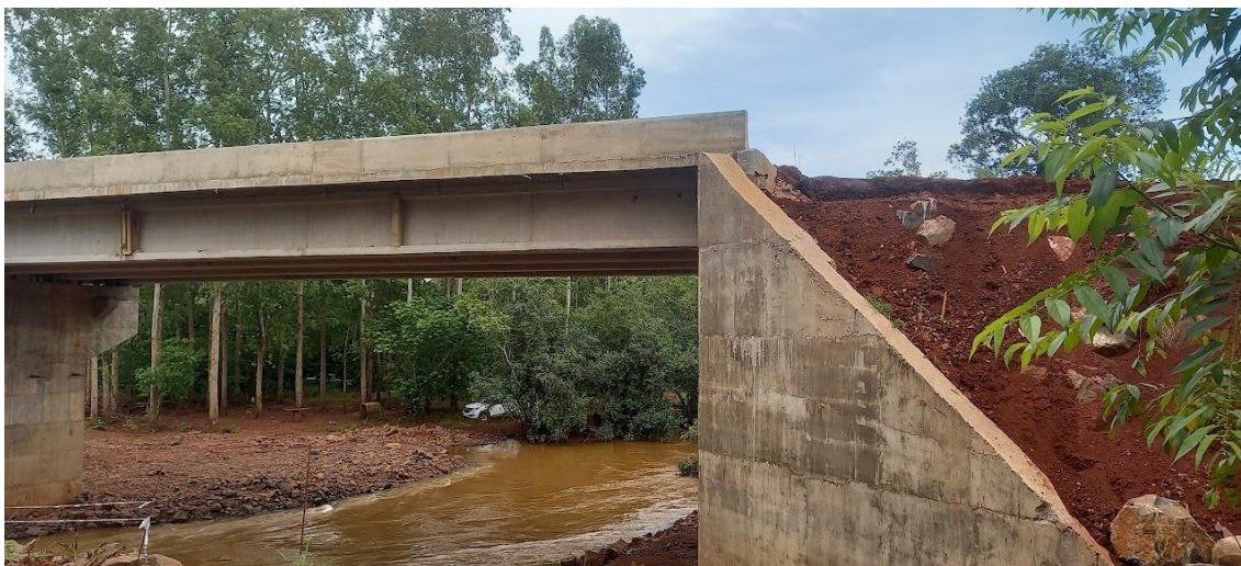
Fotografía N° 2: Viga y Losa del puente en construcción.
