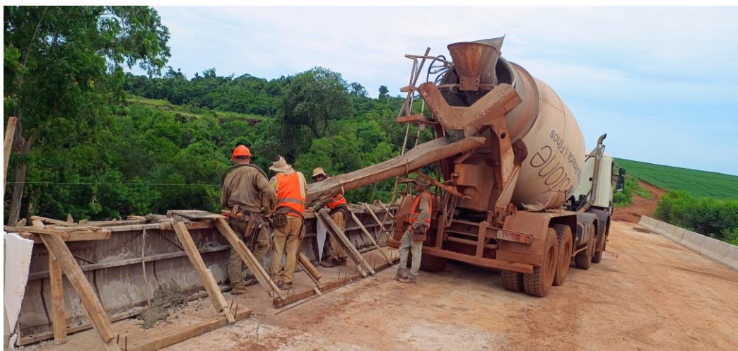
Fotografía N° 3: Hormigonado de las barreras de seguridad.
