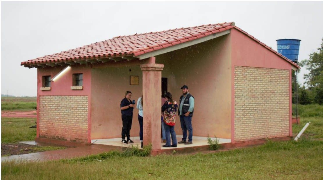
Fotografía N° 2: Consultorio ambulatorio construido
