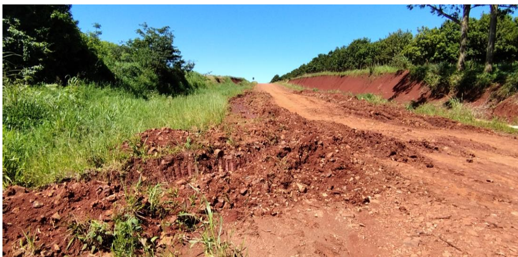
Fotografía N° 3: Tramo con problemas de erosión (La Paz – Jesús)
