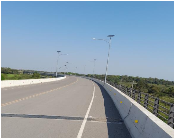
Fotografía Nº 15: Puente culminado sobre el Río Tebicuary.
