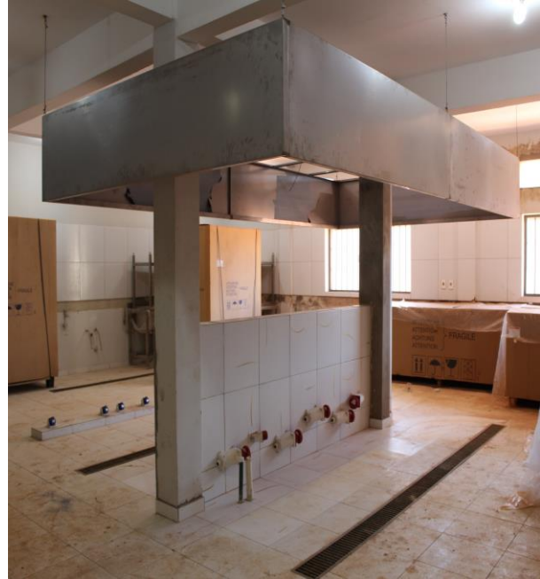
Fotografía 4: Area de cocina terminada, siendo equipada por Itaipú Binacional.
